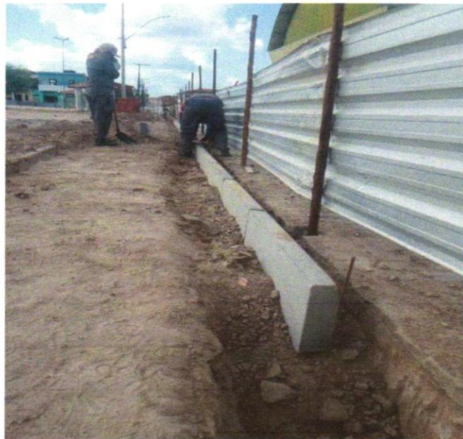
Foto 06 - ASSENTAMENTO DE GUIA (MEIO-FIO) EM TRECHO RETO, CONFECCIONADA EM CONCRETO PRÉ-FABRICADO, DIMENSÕES 100X15X13X20 CM (COMPRIMENTO X BASE INFERIOR X BASE SUPERIOR X ALTURA), PARA URBANIZAÇÃO INTERNA DE EMPREENDIMENTOS. AF\_06/2016\_P
